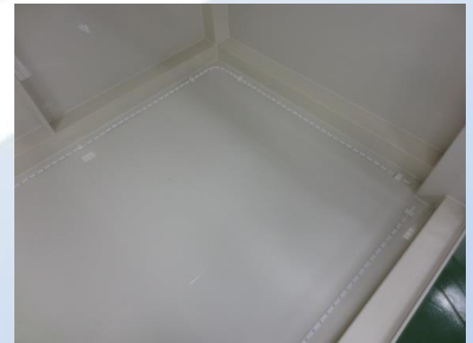
設備内漏水センサー設置
