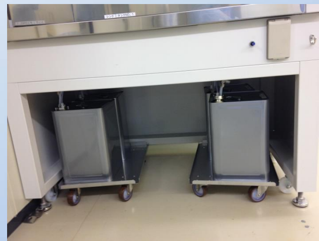
廃液回収用タンク設置(装置下台)
