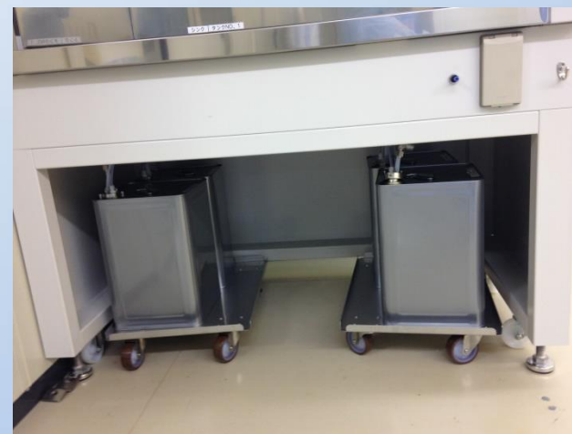
廃液回収用タンク設置(装置下台)
